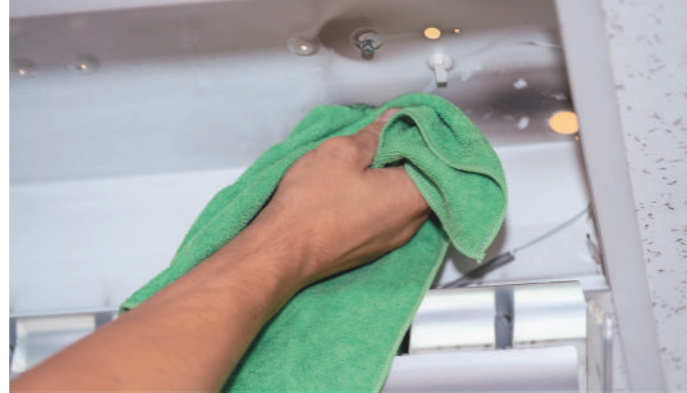
Rasterblech geöffnet, Altbestand entfernt und Gehäuse gereinigt
