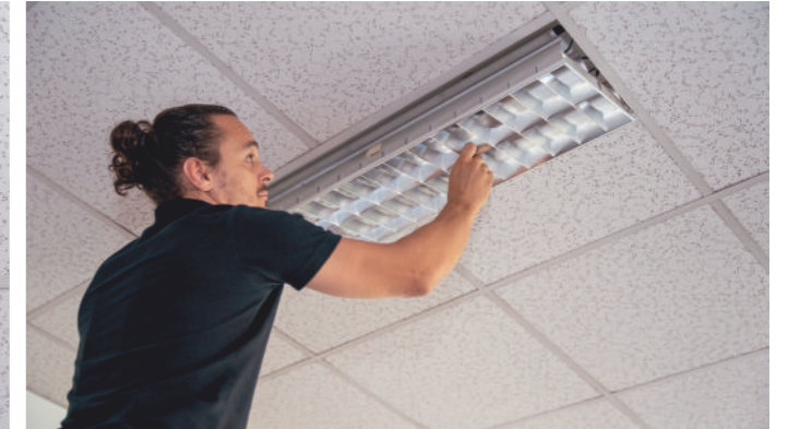
Rasterblech wieder geschlossen und fertig war die Umrüstung
