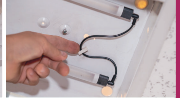
ReFIT Konverter montiert und angeschlossen, vorkonfektionierte Stecker mit Leuchte verbunden
