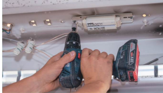
Rasterblech geöffnet, Altbestand entfernt und Gehäuse gereinigt
