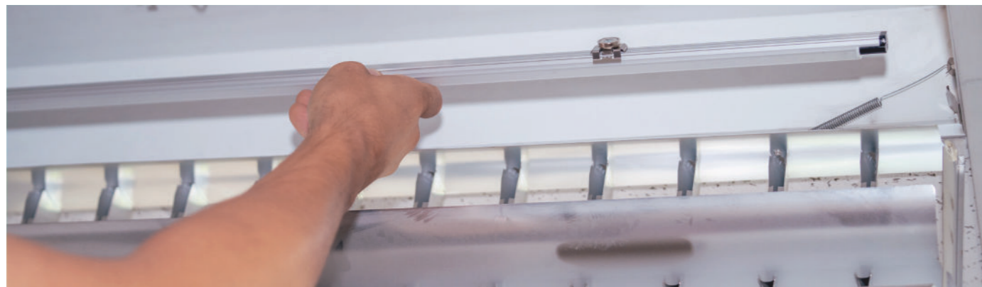
ReFIT Leuchten mittels Magnetclips montiert
