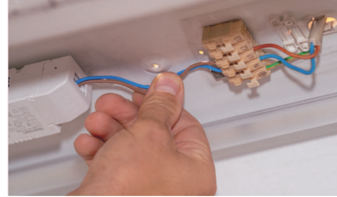
ReFIT Konverter montiert und angeschlossen, vorkonfektionierte Stecker mit Leuchte verbunden
